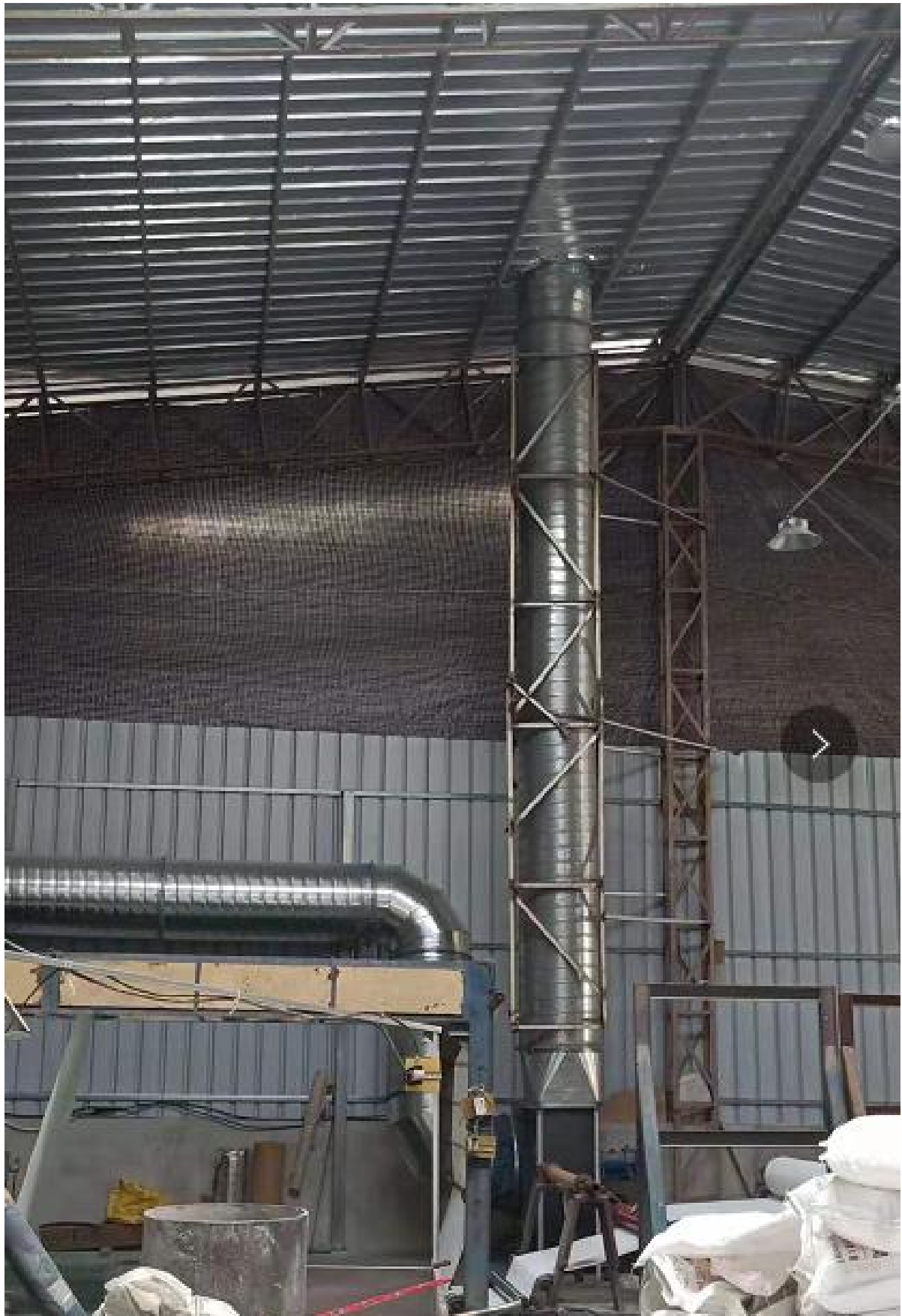
15m 高排气筒
