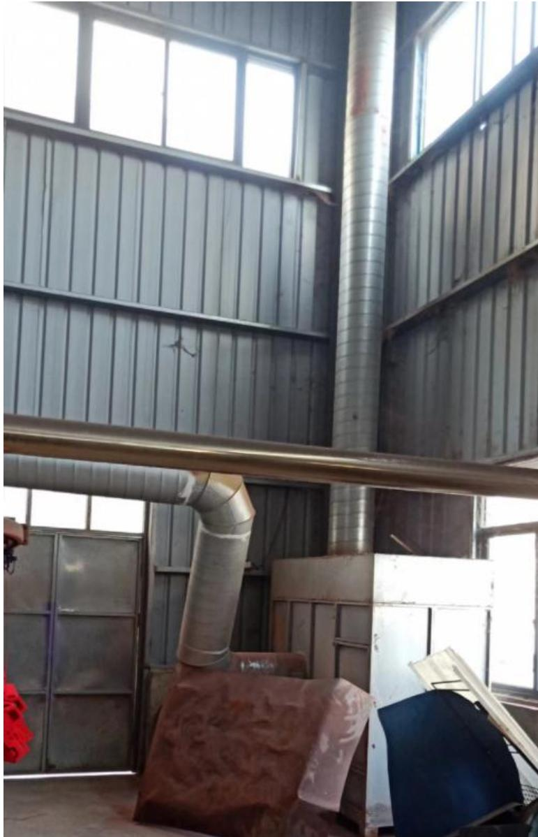
喷粉废气处理设施（粉尘二级回收装置）
