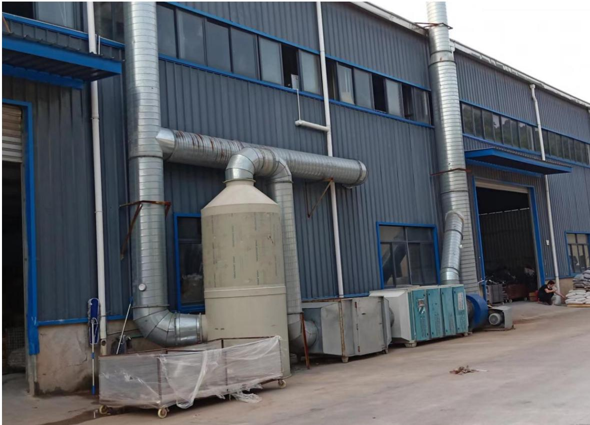
项目喷漆及彩绘工序产生的废气处理设施（水喷淋塔+活性炭吸附+UV 光解）
