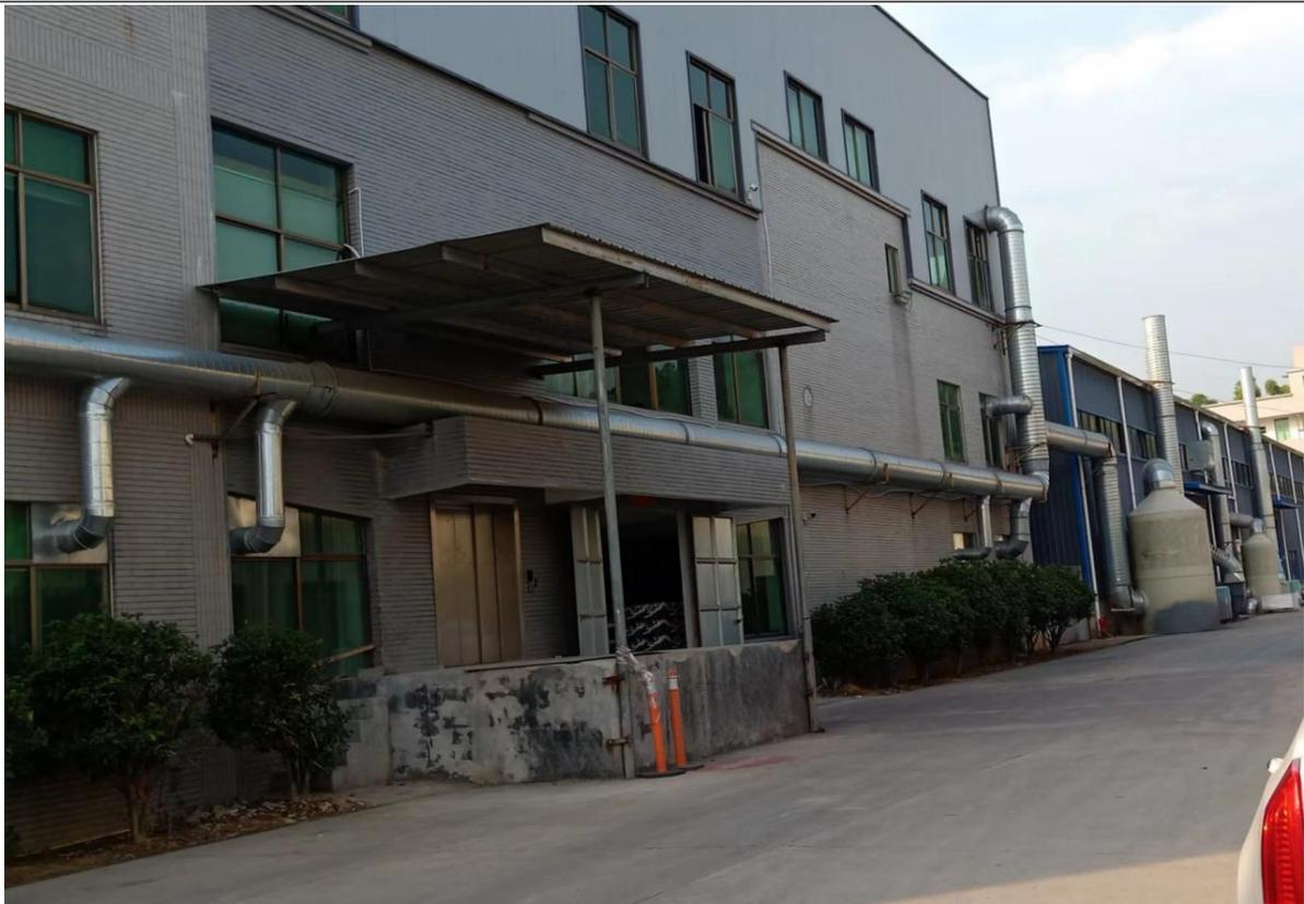
搅浆及彩绘、喷漆废气处理设施（水喷淋塔+活性炭吸附+UV 光解）
