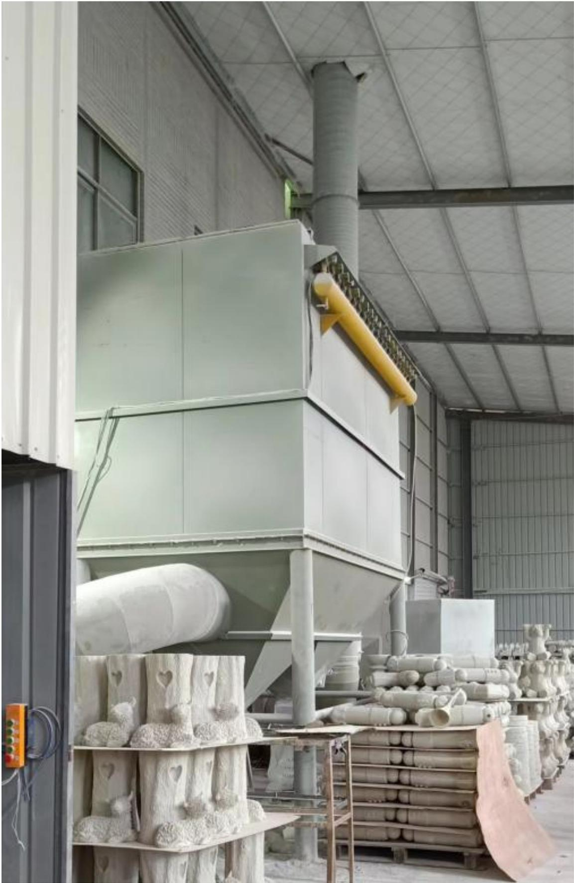
打磨、修坯废气处理设施（布袋除尘+15m 排气筒）
