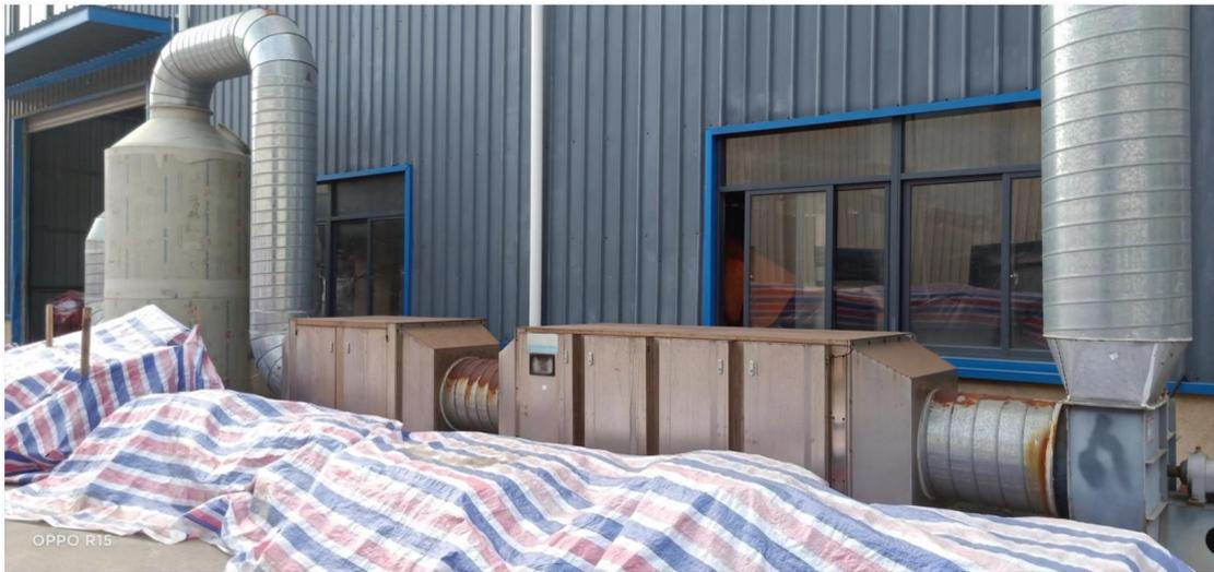
项目喷粉固化废气处理设施（水喷淋塔+活性炭吸附+UV 光解）
